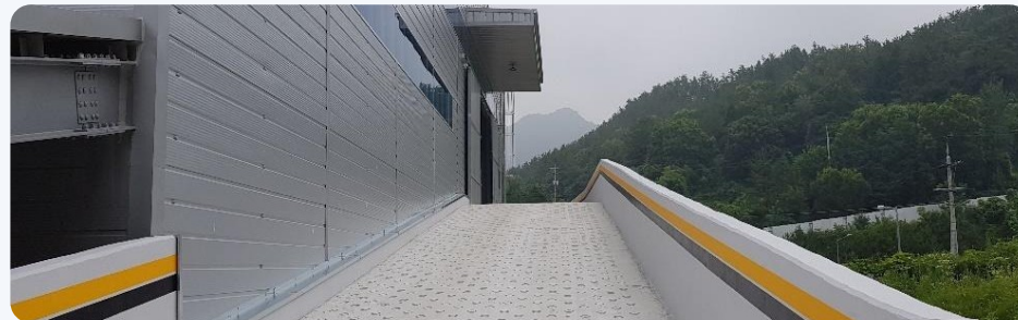
2층 진입 램프 2층까지 차량 진입 가능
