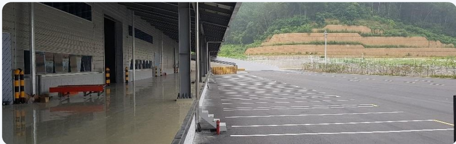
On-dock 시스템 도크 시설 · 차량 직접 상하차
